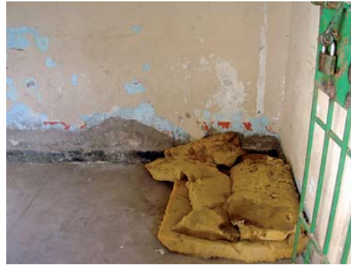
Estado de la celda en la Comisaría de La Joya – Arequipa
