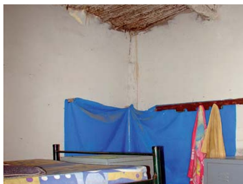
Daños en los dormitorios del personal policial de la Comisaría de Paiján, (Trujillo)
