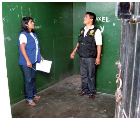
Estado de la celda de la Comisaría de Casma - Chimbote
