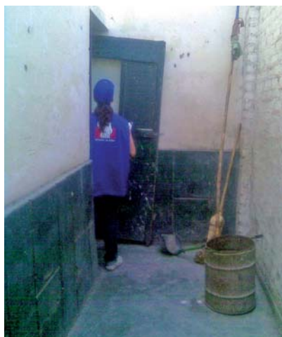
Puertas en mal estado de la Comisaría de Pucalá, (Lambayeque)
