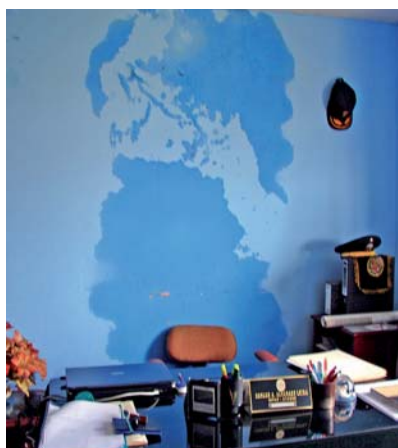
Daño producido por las lluvias en las paredes de la Comisaría de Buenos Aires (Trujillo)
