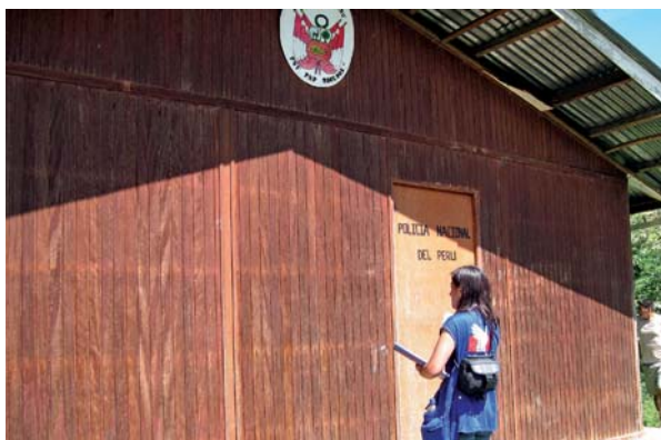
Puesto de Vigilancia Fronterizo Moreros
